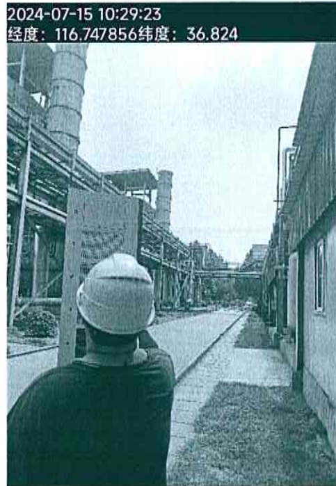
3#燃气轮机组排气筒 (DA018)
