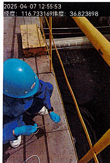
三期酚氰废水处理站清水池
