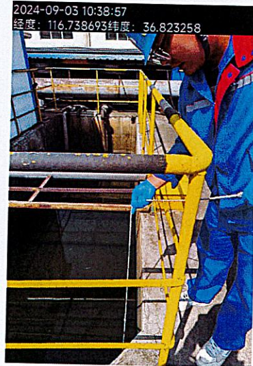
三期酚氰废水处理站清水池
