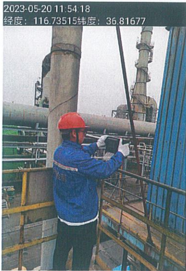
2023-05-20 11:54:18 经度: 116.73515 纬度: 36.81677 炭黑 6#细粉袋滤器排气筒 (DA035)
