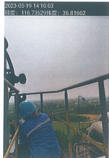
2023-05-19 14:10:03 经度: 116.73629 纬度: 36.81602 炭黑 5#6#收集袋滤器排气筒 (DA034)
