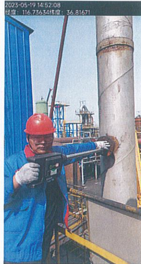
2023-05-19 14:52:08 经度: 116.73634 纬度: 36.81671 炭黑 5#细粉袋滤器排气筒 (DA036)
