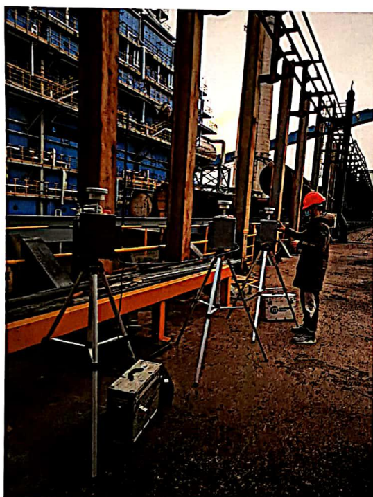
三期焦炉炉端焦侧 2/3 处
