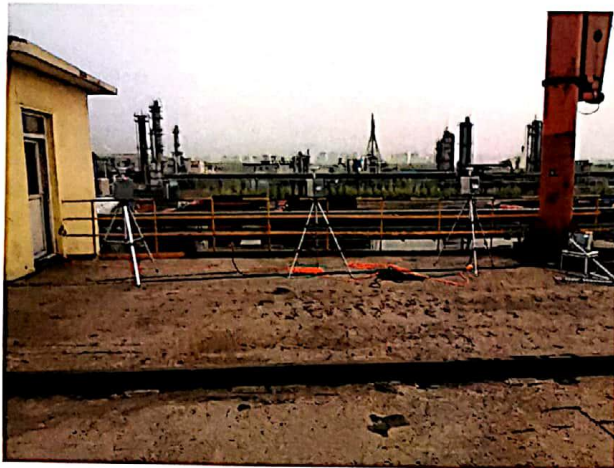
二期焦炉炉端机侧 1/3 处
