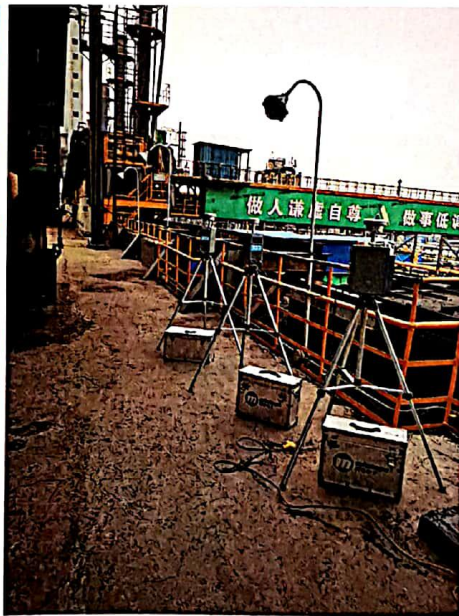
三期焦炉炉端机侧 2/3 处
